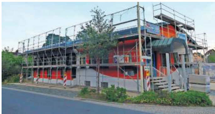
Noch Baustelle, aber Mitte Dezember sollen die Umbauarbeiten abgeschlossen sein.
