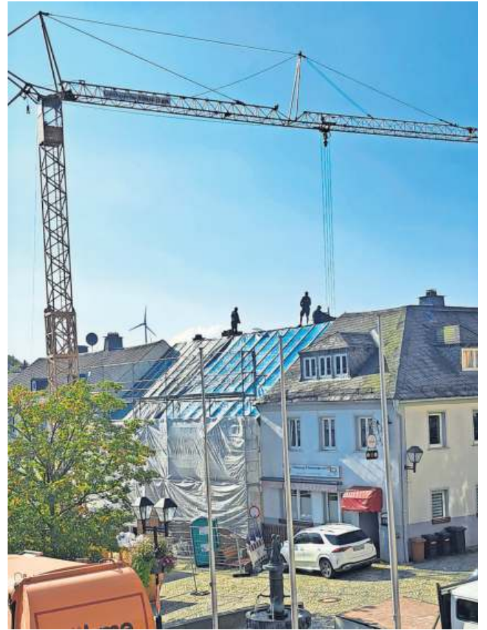
Die Baustelle in der Vorderansicht.
