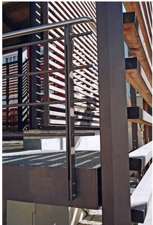
Fluchttreppe, Geländer, Verkleidung
