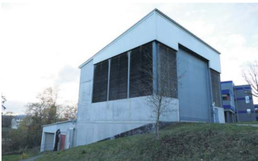
Das Hackschnitzelwerk der Stadt Naila.
